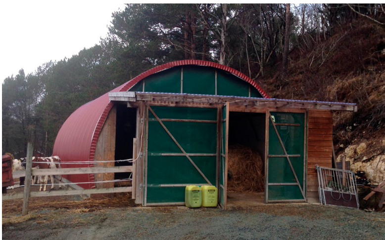
Stålbuehallen er inndelt i flere samlebinge. De største kalvene har tilgang til uteareal, når været tillater det. Lager for halm og fôr i front, med vindbremseduk for lunt klima. Bjugn. Foto: Knut Ingolf Dragset
